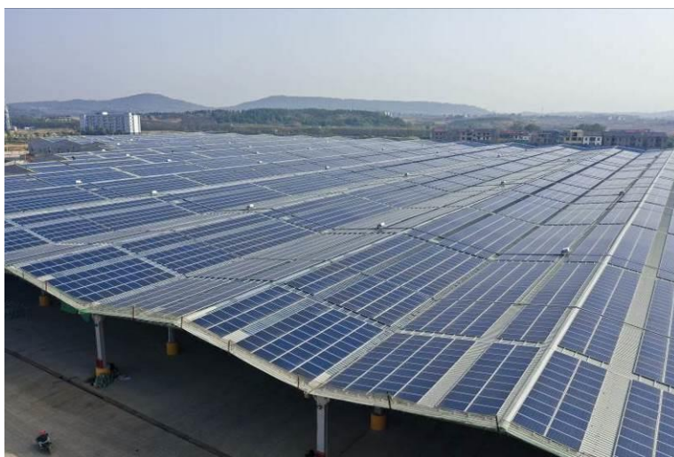
发行人江西丰城生产基地光伏厂房
