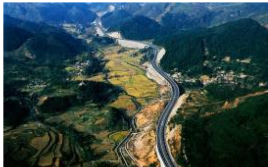
贵阳至新寨（黔桂界）高速公路
