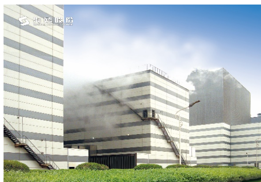
华能北京热电有限责任公司（北京） 10 台 NH-5000 型冷却塔
