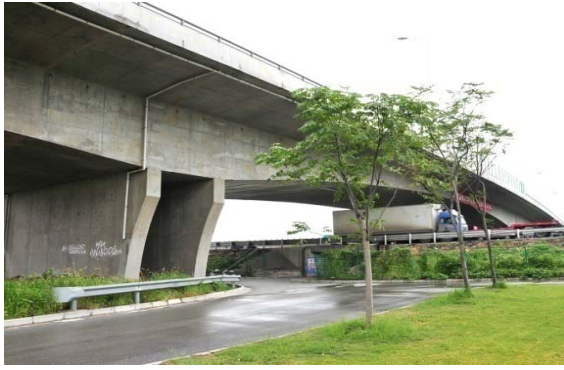
香楠路跨沪宁高速公路桥
