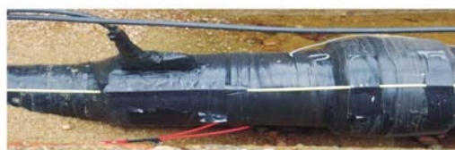
电缆接头上光纤光栅传感器应用
