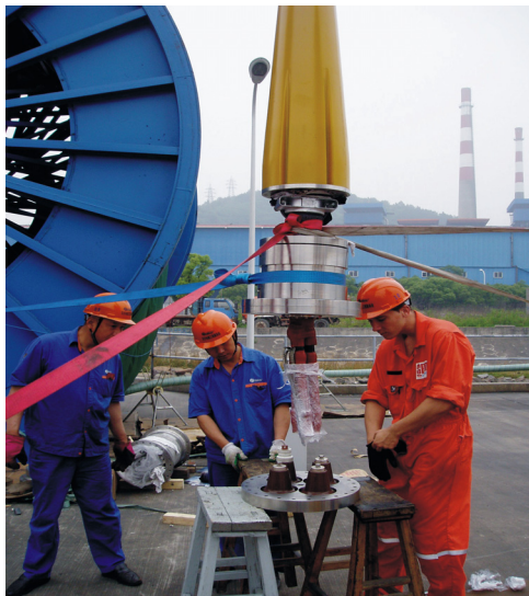
公司的动态脐带缆终端安装现场
