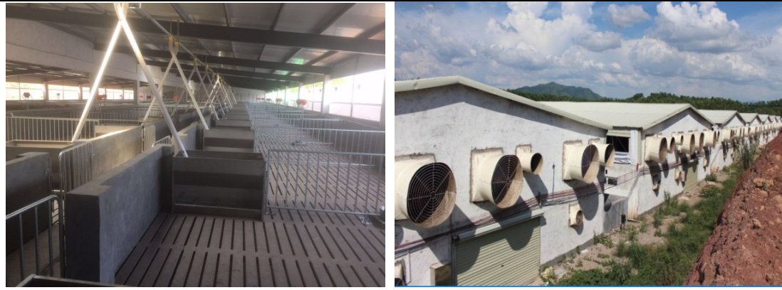
全漏缝地板结构及温控通风系统
