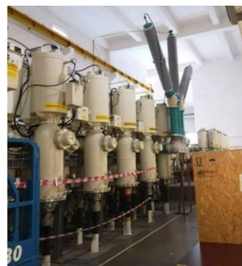
GK-260kV/83A 谐振电抗器及试验现场
