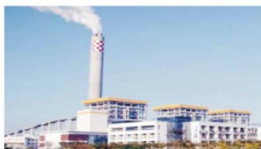
中国华能电力集团海丰电厂 2 × 1000MW脱硝工程催化剂供货
