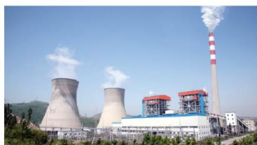
中国华能集团莱芜电厂 2 × 1000MW脱硝蜂窝式催化剂供货
