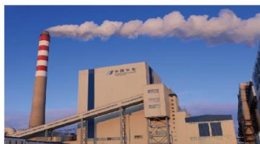
中国华能集团内蒙古白音金山发电有限公司 1 × 600MW脱硝改造工程催化剂供货
