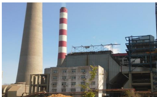
鹤壁同力项目现场
