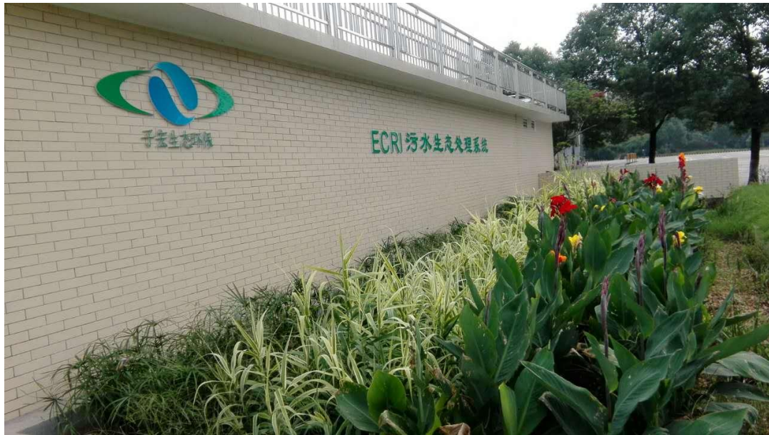
服务区生活污水处理
