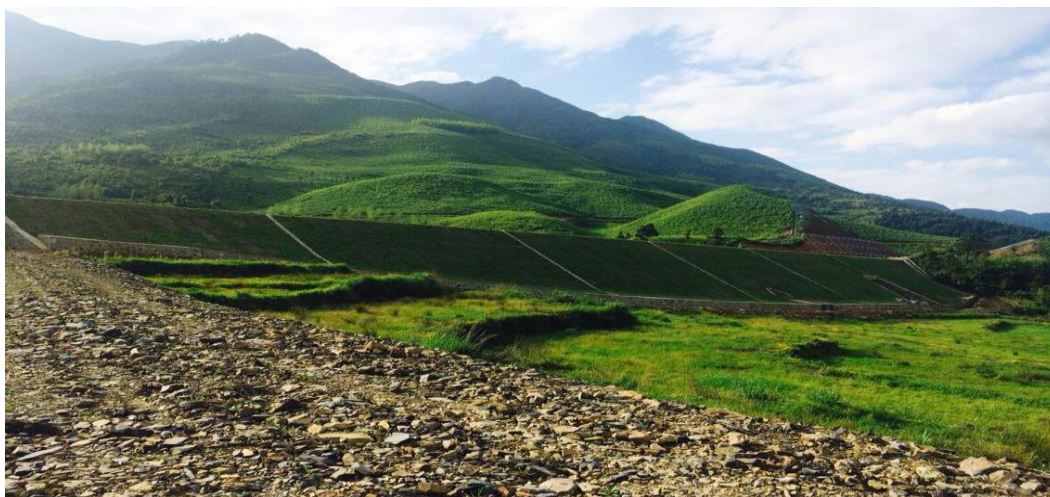
建设期采用 S2E 生态植生产品护坡技术（2）
