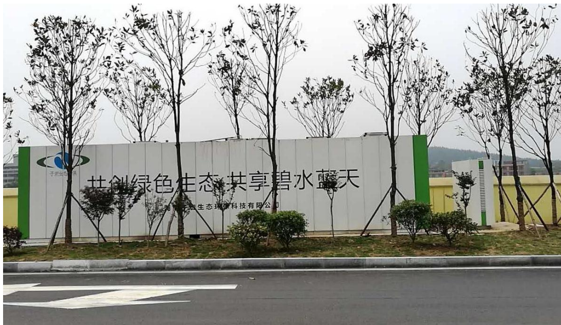
服务区生活污水处理（设备类）
