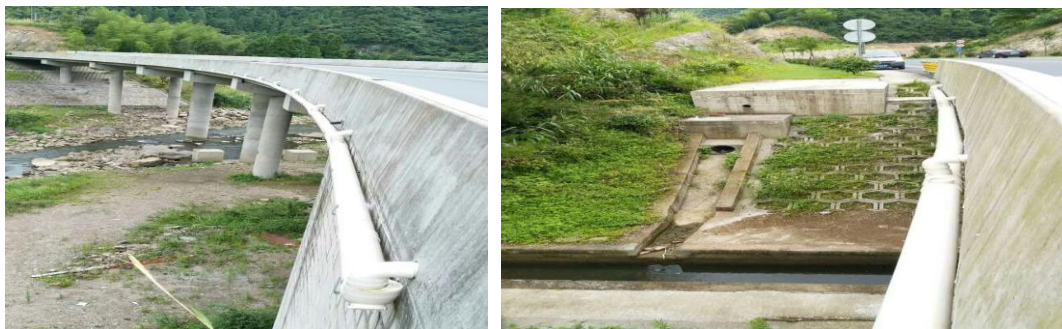
建设期采用路面桥面径流收集处理系统
