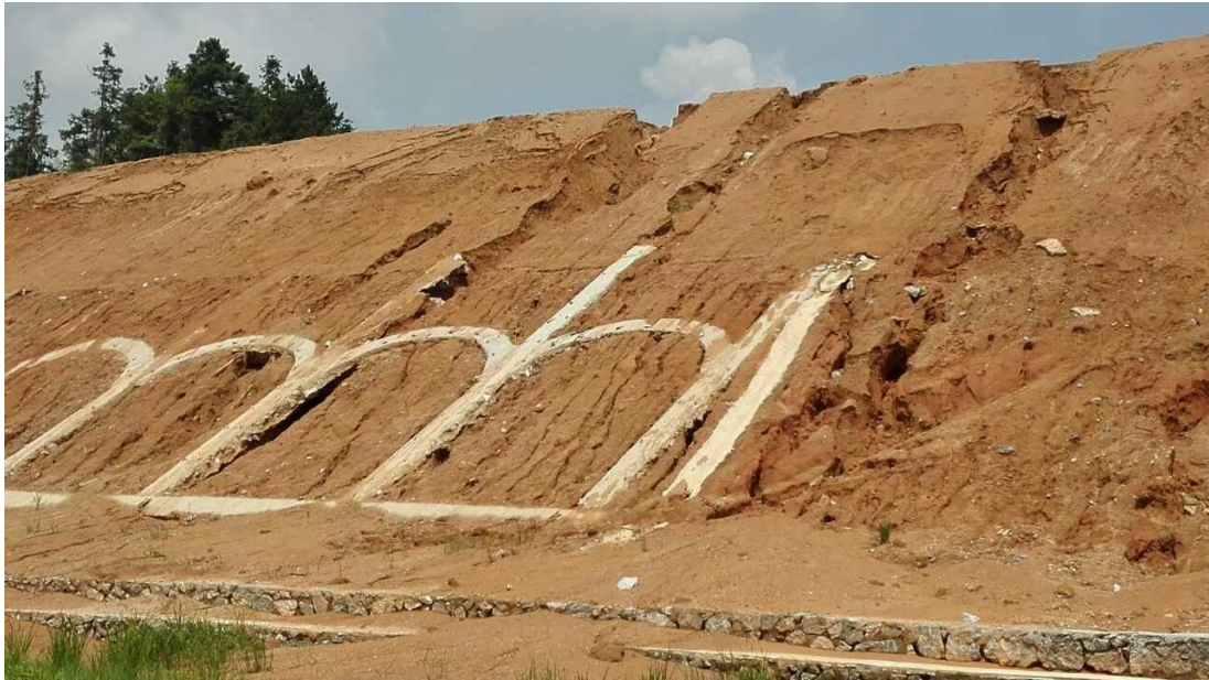
高速公路建设期边坡水土流失问题严重
