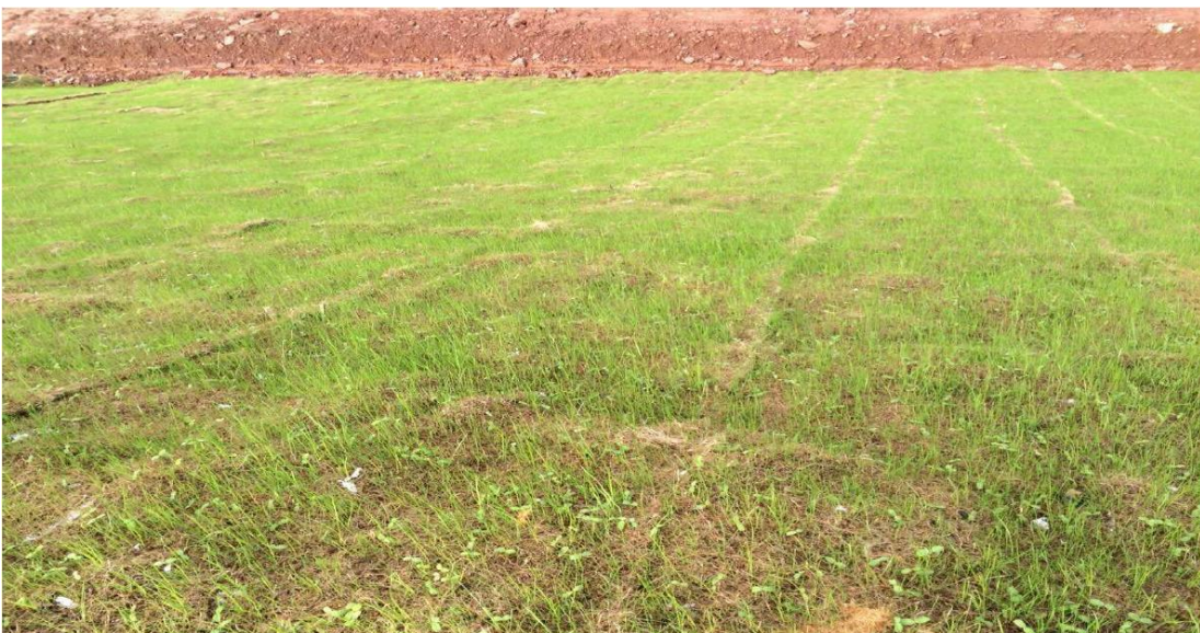
建设期采用 S2E 生态植生产品护坡技术（1）
