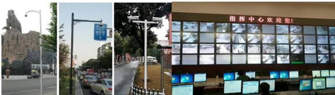
社会面治安监控系统系统前端
