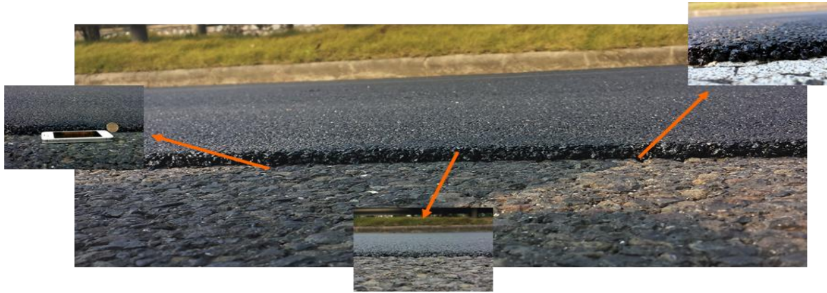
(微罩面施工示意图)
