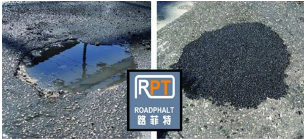
(全天候冷补料修复施工示意图)
