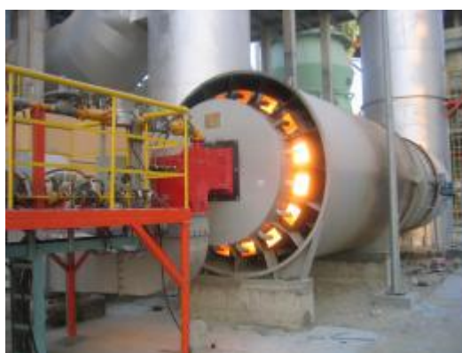
油气两用负压热风炉应用现场
