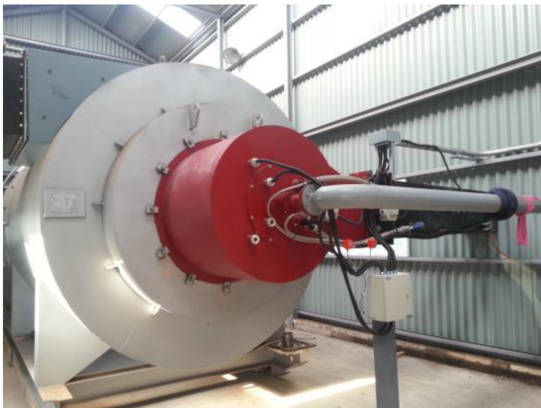
煤粉燃烧器应用于热风炉
