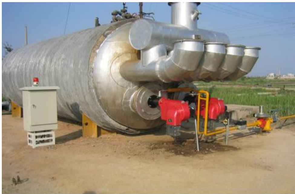
一炉双机 JSTG200T 型燃烧器应用现场
