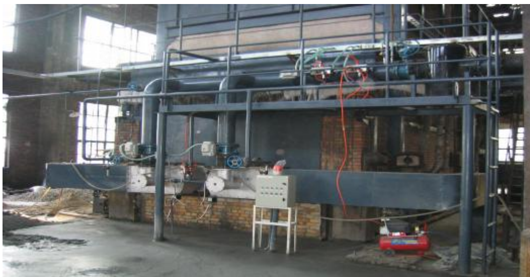
2×JST1200J 型燃烧器与 40 吨燃煤改燃气蒸汽锅炉配套使用应用现场
