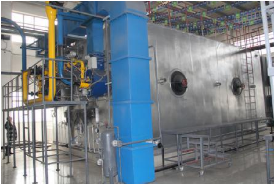
煤粉燃烧器应用于热水锅炉
