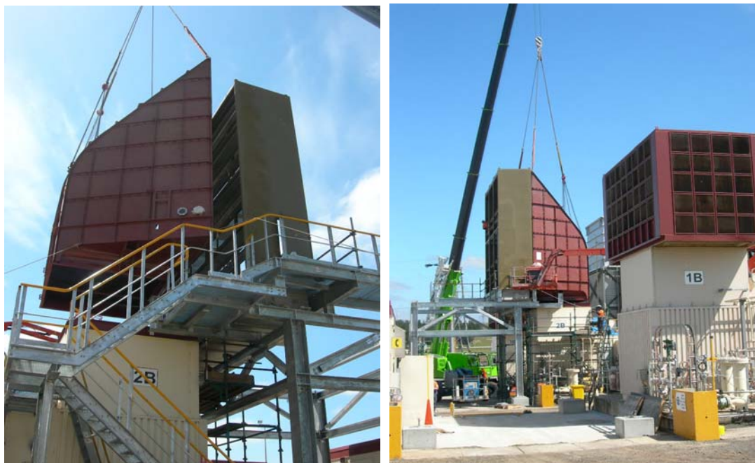
燃气轮机进气系统安装现场
