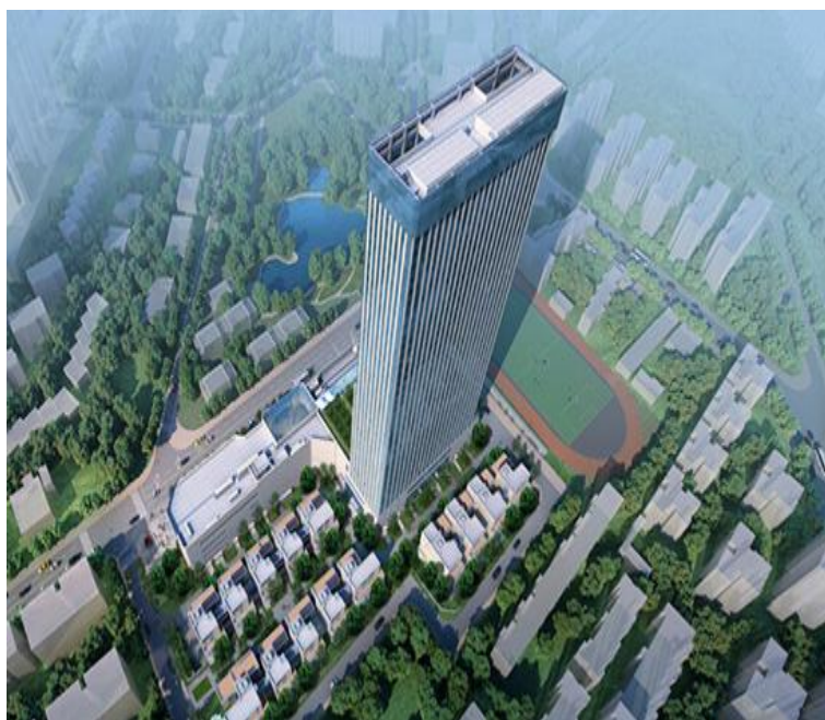
东南航运中心总部大楼 AB 栋（在建）
