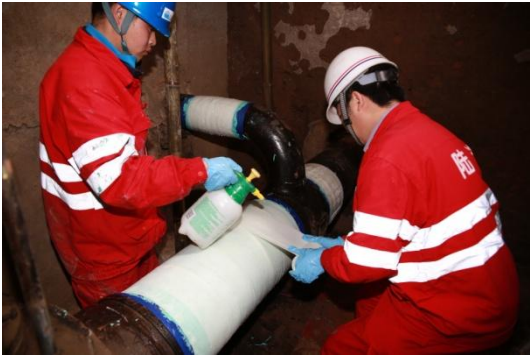
管道修复示意图——预浸复合材料修复系统 LD PolyWrap™
