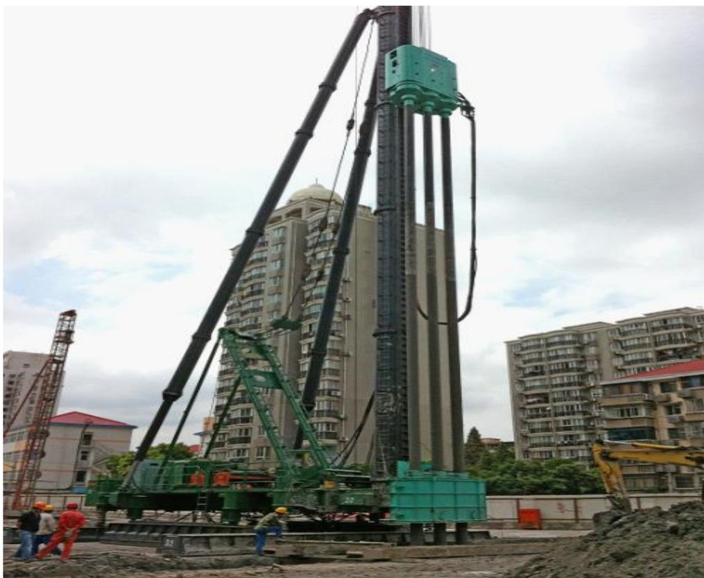
（搅拌机与 H 钢、拉森钢板桩结合的 SMW 工法）
