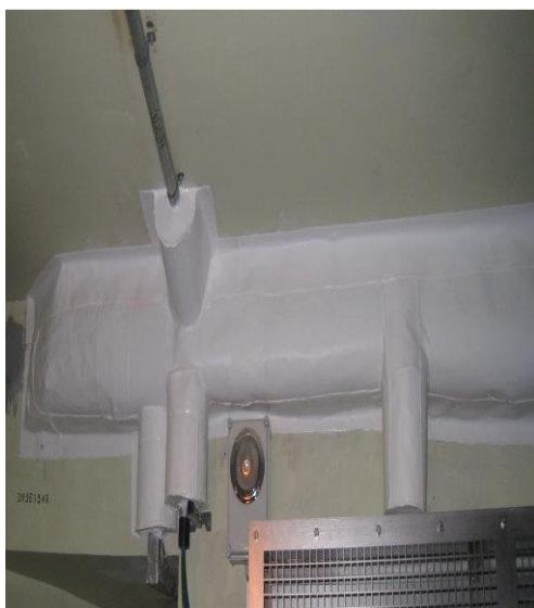
电缆和电缆桥架三面包覆带膨胀模块
