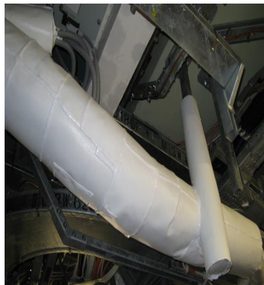
电缆和电缆桥架四面包覆带膨胀模块
