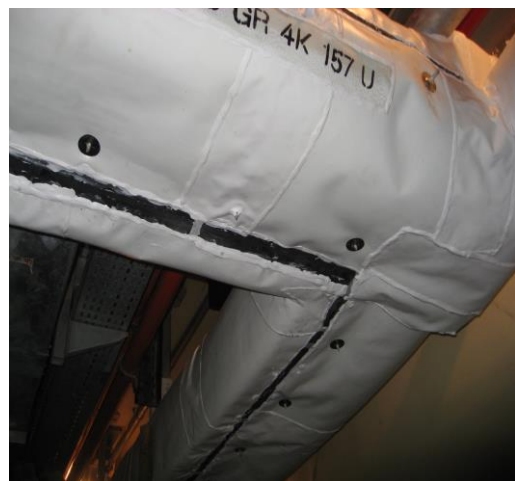
电缆和电缆桥架四面包覆带膨胀模块
