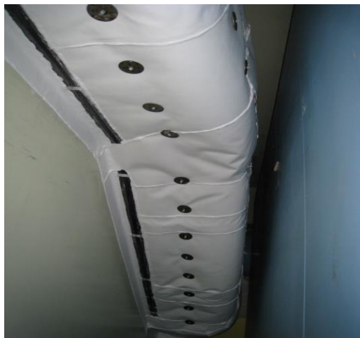
电缆和电缆桥架三面包覆带膨胀模块
