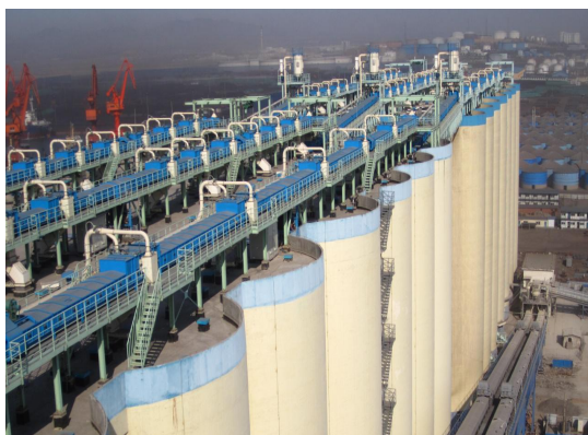
双犁式全封闭多点卸料带式输送机
