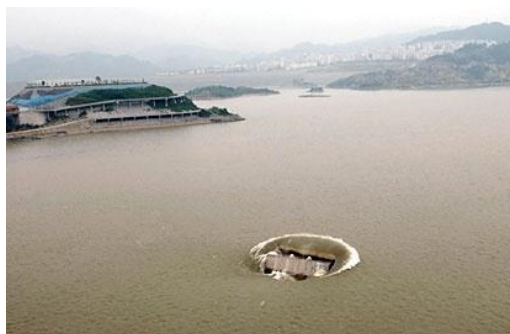
三峡工程三期 RCC 围堰 15 堰块水下爆破拆除
