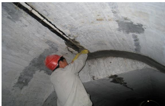
厂房裂缝封闭处理
