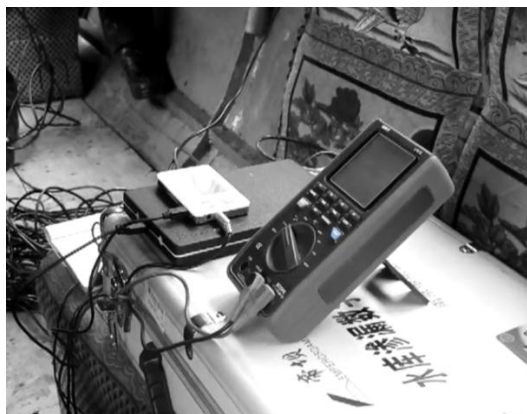
采用三维矢量流速声呐技术探测渗漏区域
