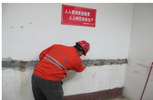
厂房裂缝封闭处理
