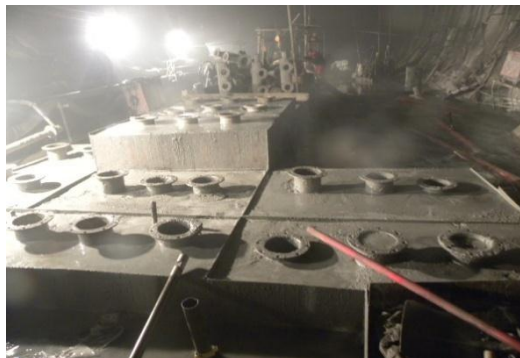
盖重混凝土浇筑封堵后效果
