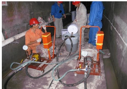
厂房顶结构缝涂刷SPU防水材料
