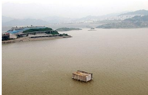
三峡工程三期 RCC 围堰 15 堰块拆除前
