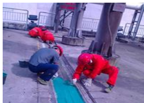
厂房顶结构缝涂刷SPU防水材料
