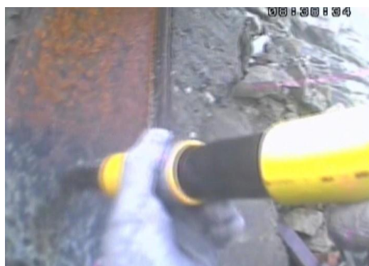
水下金属结构无损探伤
