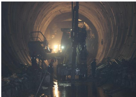
多功能凿岩台车钻孔
