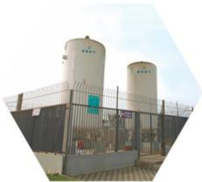
由液氧贮槽、汽化器、减压装置、管道以及报警装置等组成。有严格的安装场地要求，低温容器存在安全隐患、氧气需购买、运输，且存在自然蒸发耗
