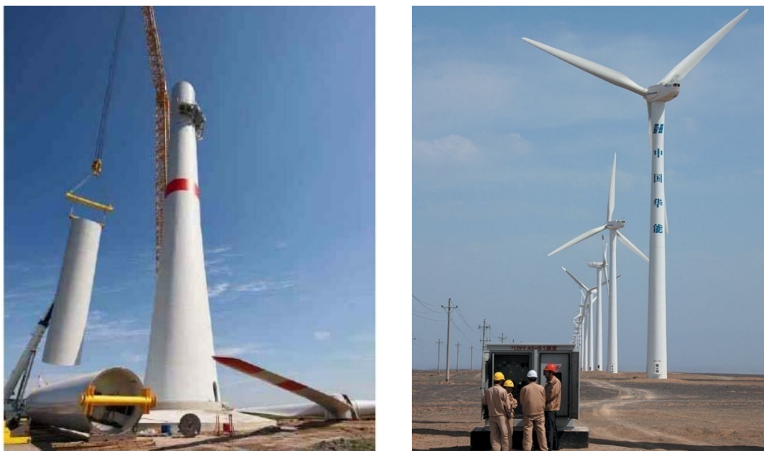
风力发电塔筒安装现场
