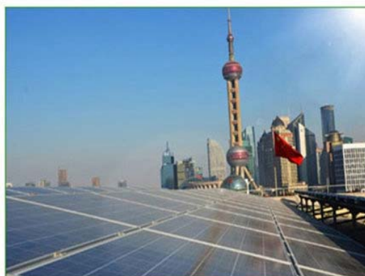
地点：上海 中国银行 装机容量150kw
