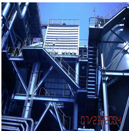
图 1-5.（冶金焦化行业除尘应用实例）
