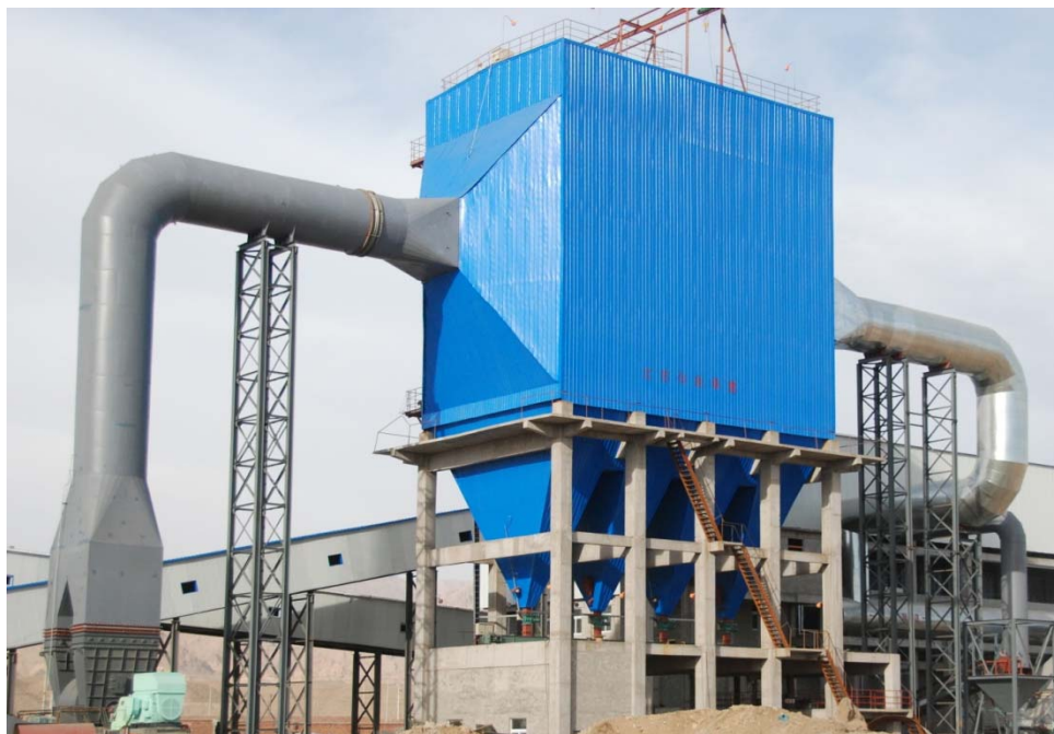
图 2-3. FD 型电除尘应用实例
