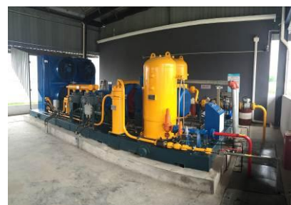
天然气增压装置
