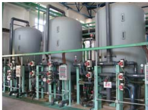
公司为太仓协鑫发电有限公司研制的离子交换设备
