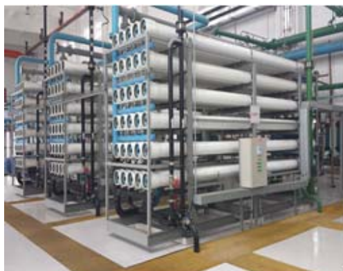
公司为江苏望亭电厂研制的 的 RO 反渗透设备
