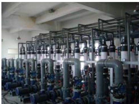
公司为太仓协鑫垃圾焚烧发电有限公司研制的 外置式 MBR 膜设备
