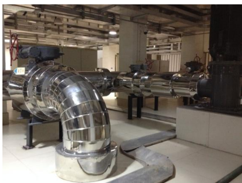
水电机组机坑外技术供水管道保温
