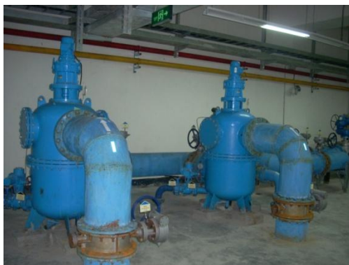
结露引起水电设备生锈
