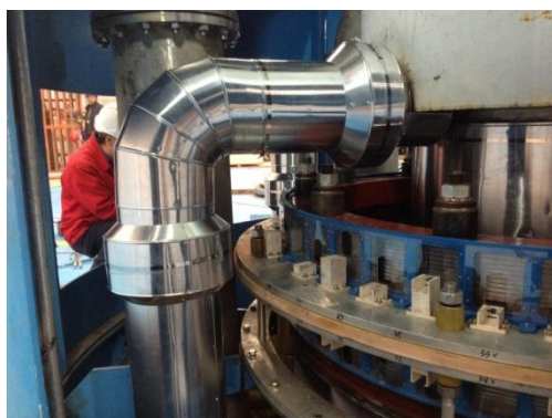
水电机组中心补气排水管道保温
