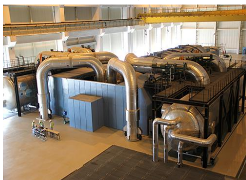
核电汽轮发电机组保温
