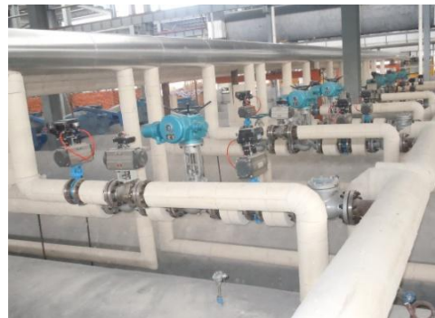
高温蒸汽架空管道保温
