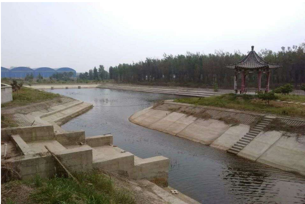
邯郸富润沉淀池实景拍摄
