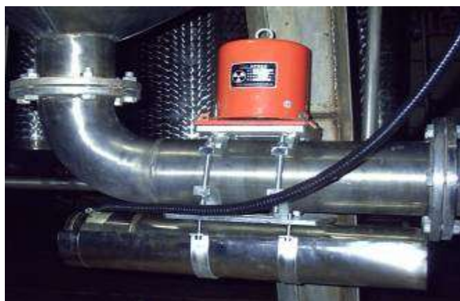
核子料位（液位）计工艺现场安装示意图
