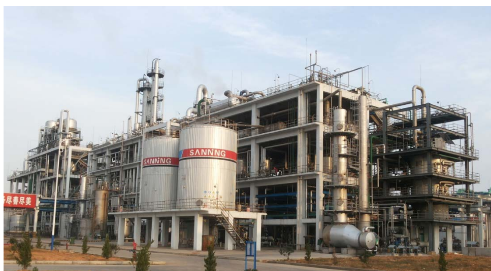
图四：氨肟化反应装置
