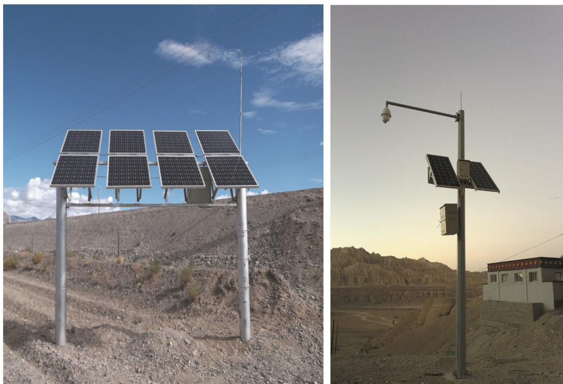
西藏阿里地区公安边防支队太阳能设备监控系统
