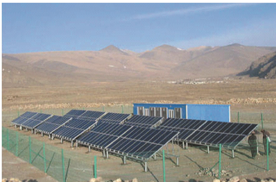
西藏山南30KM离网电站
