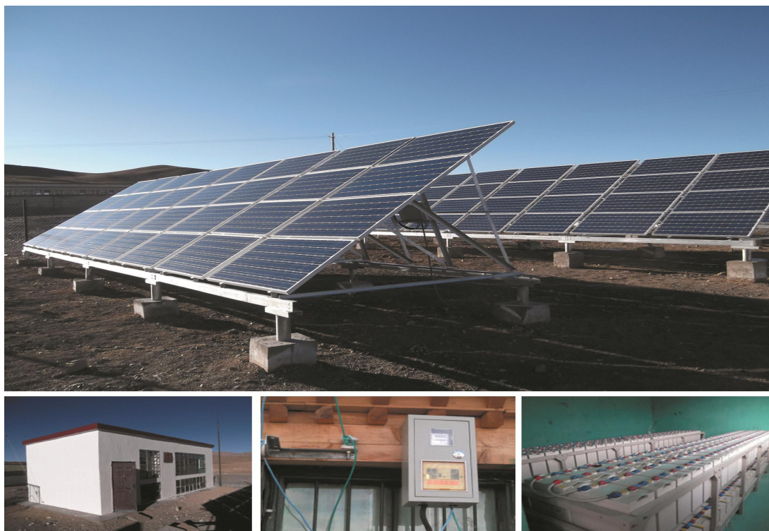
西藏那曲地区班嘎县金太阳工程
