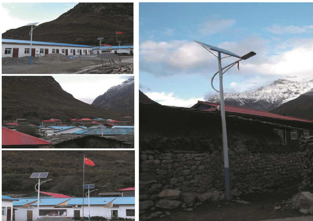
西藏林芝地区波密县太阳能路灯项目
