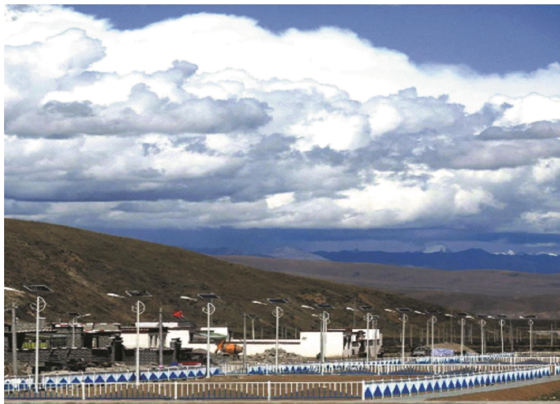
西藏那曲地区太阳能路灯项目
