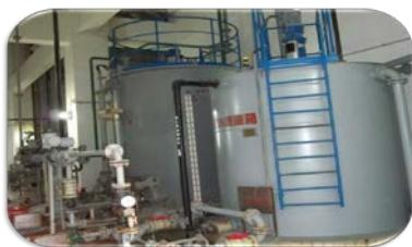
(2) JYMBR 膜生物反应器中所采用的膜元件可以承受很高的污泥浓度，MLSS 能达到 8000-10000mg/L。单位容积的生化池污泥量是普通生化池的 3-5 倍，从而大大提高了生化处理能力。同时系统取消了二沉池，减少了构筑物的尺度、使占地面积大大减少；
