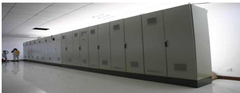
控制系统把传统分散控制方式的几十台原料处理设备中的几百乃至上千个控制点进行系统整合，按原料进仓输送存储、原料出仓输送清理和原料粉碎调浆等工序进行分区，集成在一个控制平台下进行远程监控与操作，实现了整套系统的自动化运行。
