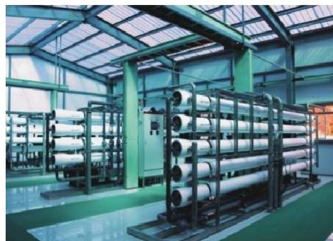
部分有机物；NF/RO/ED 集成膜工艺可实现 90~95%的水量回收。
