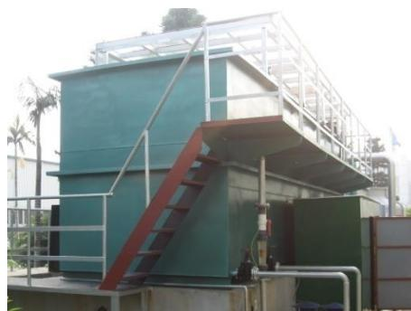
技术性能：出水水质 SS 等指标达到甚至超过自来水水质标准；水资源回用率超过 90%；易操作，易维护，低噪音。
