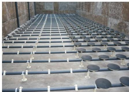
技术性能：可以改善滤池内各点滤速一致性和滤池的反冲洗效果，从而实现过滤效率的提高；滤池滤层无块状结饼，滤池过滤通量无明显衰减。
