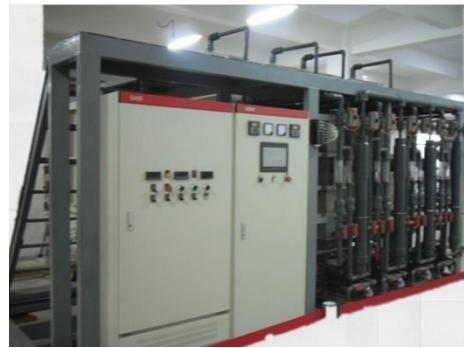
技术性能：出水水质可达《电镀污染物排放标准》(GB21900-2008)的要求；无二次污染；使用方便、易于控制。
