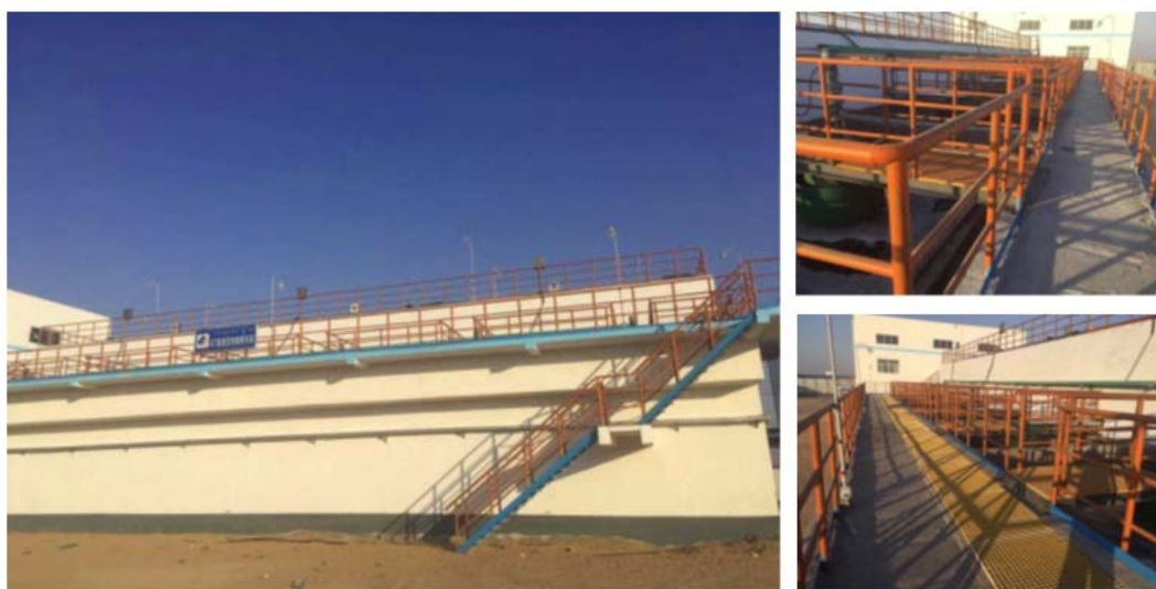
五原县隆兴昌镇再生水厂
