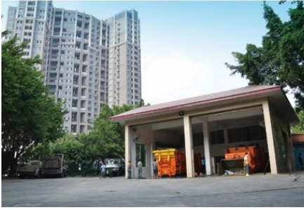
垃圾压缩中转站全貌
