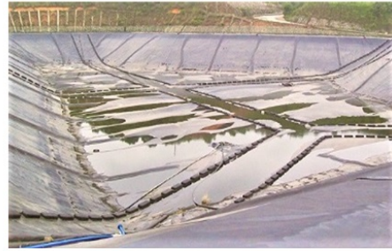
垃圾填埋场内渗滤液收集
