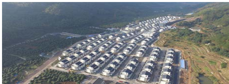
大型光伏村(宁波 鄞州区李岙村) 300kW
