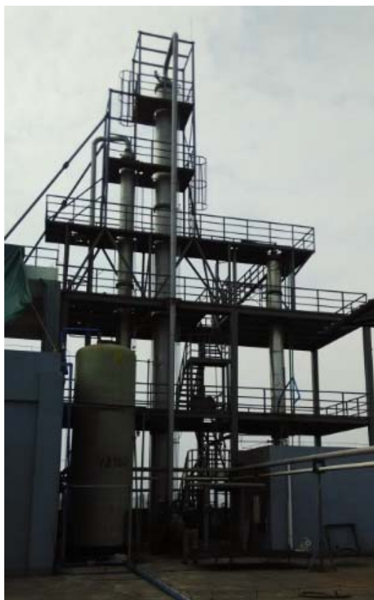
图 1 年产 1 万吨乙二醇二乙酸酯反应精馏生产装置
