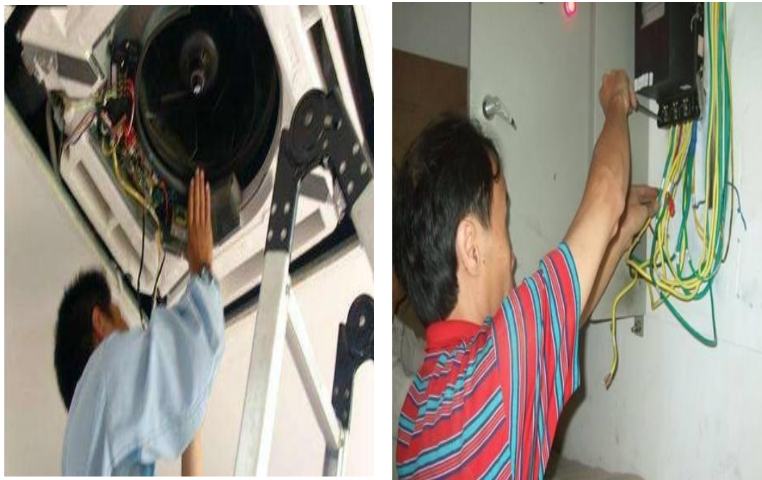
上图为维修人员进行空调及电路维修服务
