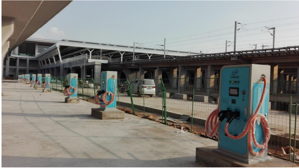
智行科技新能源汽车充电设备位于昆明火车南站（高铁站）安装示例图
