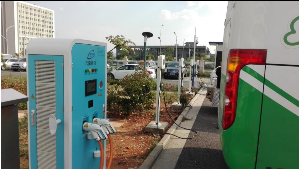
智行科技新能源汽车充电设备位于昆明长水机场安装示例图
