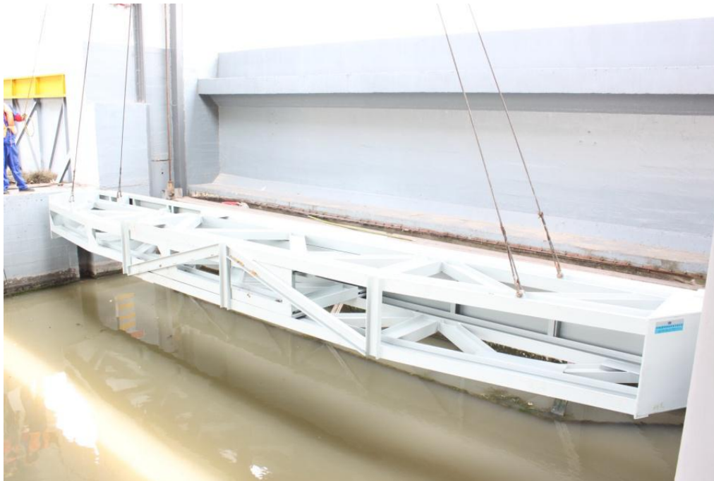
可变宽度叠梁式检修闸图例
