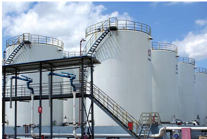
图 2-9 工厂内立式储罐图
