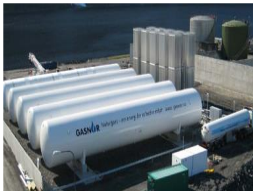
低温液体储罐（卧式）
