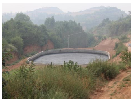
一号沼液沉淀池
