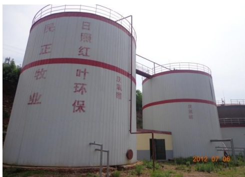
3000 立方厌氧发酵罐
