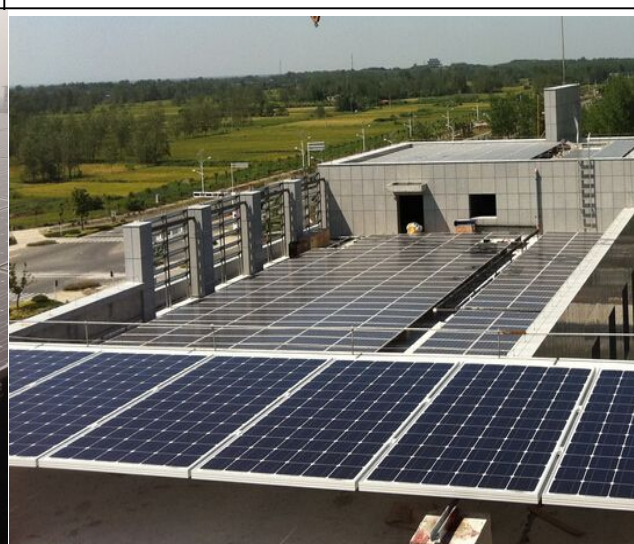
高邮菱塘建筑屋顶分布式光伏电站项目
