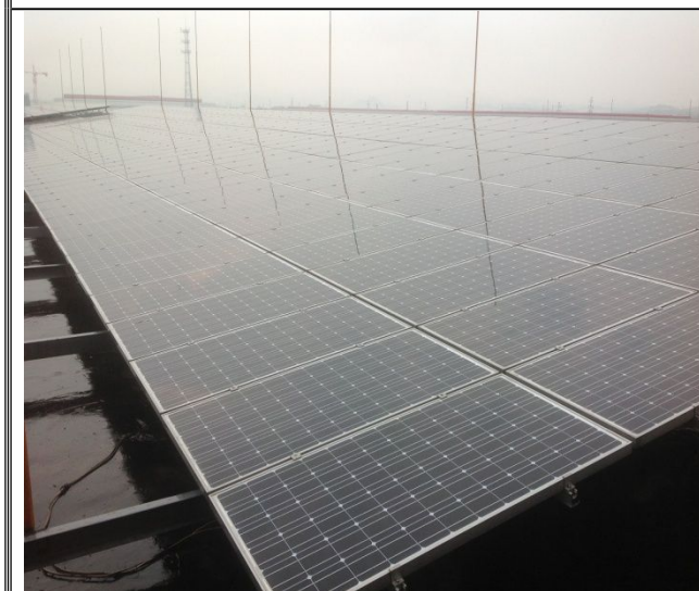
西安天虹建筑屋顶分布式光伏电站项目
