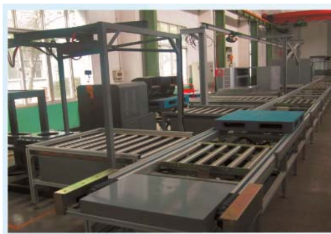
图2：空调风机检修流水线
