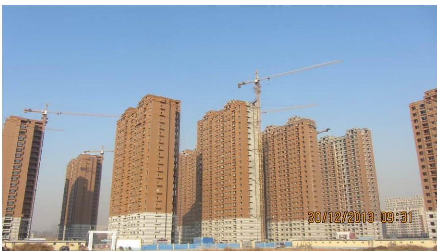
淄博范家村小区外墙保温项目
