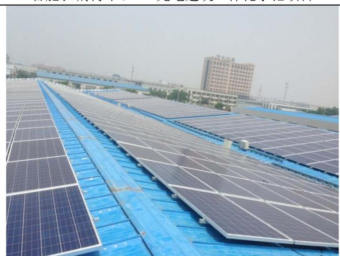
铜陵东市电子 2MW 光电建筑一体化应用示范项目
