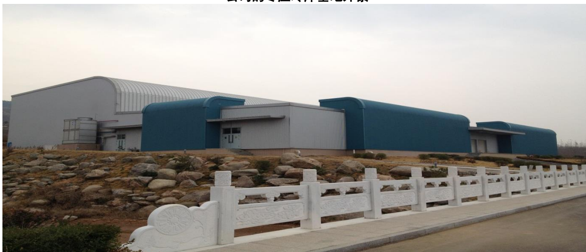
公司的枣庄冷库基地外景
