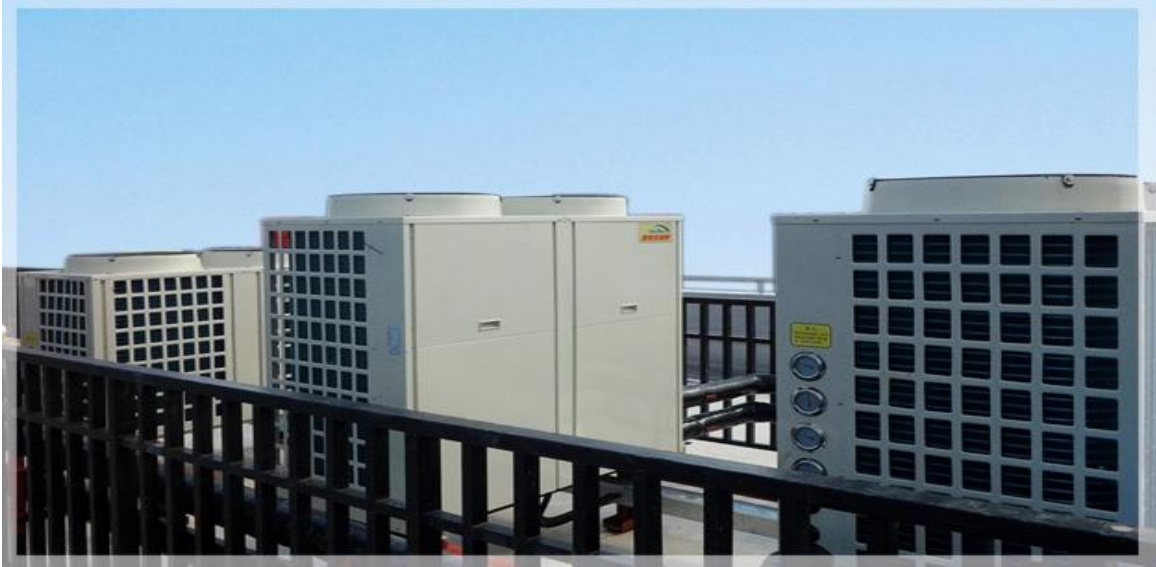
图：安装于上海某如家酒店的空气源热泵模块
